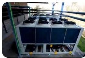
**E** La utilización de las condiciones ambientales externas (temperatura media de 13,6°C anual) y la implementación de la tecnología de **free cooling** y los **recuperadores de calor**, garantiza una temperatura óptima en los DataBOX con el mínimo consumo energético, lo que convierte el complejo en un centro de datos altamente eficiente. Con DataBOX, Adam ha instalado un nuevo CPD en un tiempo impensable en entornos tradicionales B&M.
